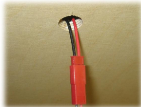
Kuva 2. Kytke ledit pikaliittimiin. Liitä ledit heti kiinni, jotta vältetään liitinjohtojen karkaaminen paneelin taakse ulottumattomiin.
